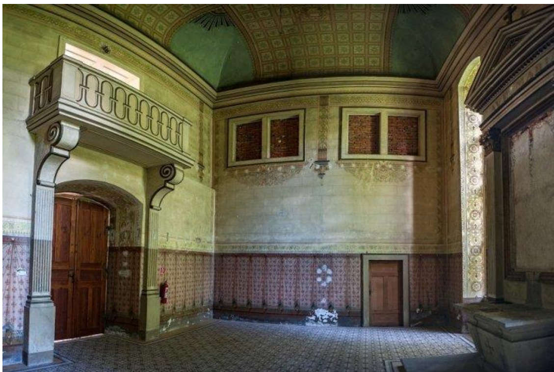
Pozostatky interiéru kaplnky v letnom sídle banskobystrických biskupov – súčasný stav 83
