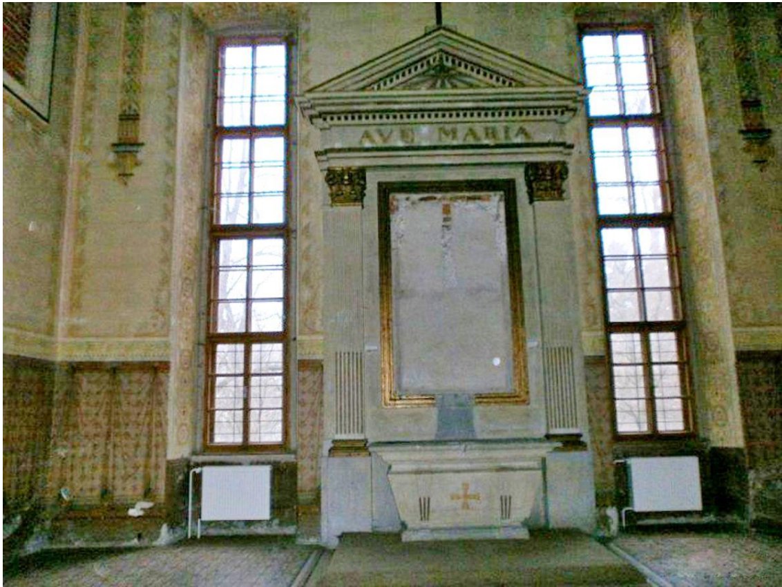
Pozostatky interiéru kaplnky v letnom sídle banskobystrických biskupov – súčasný stav 84
