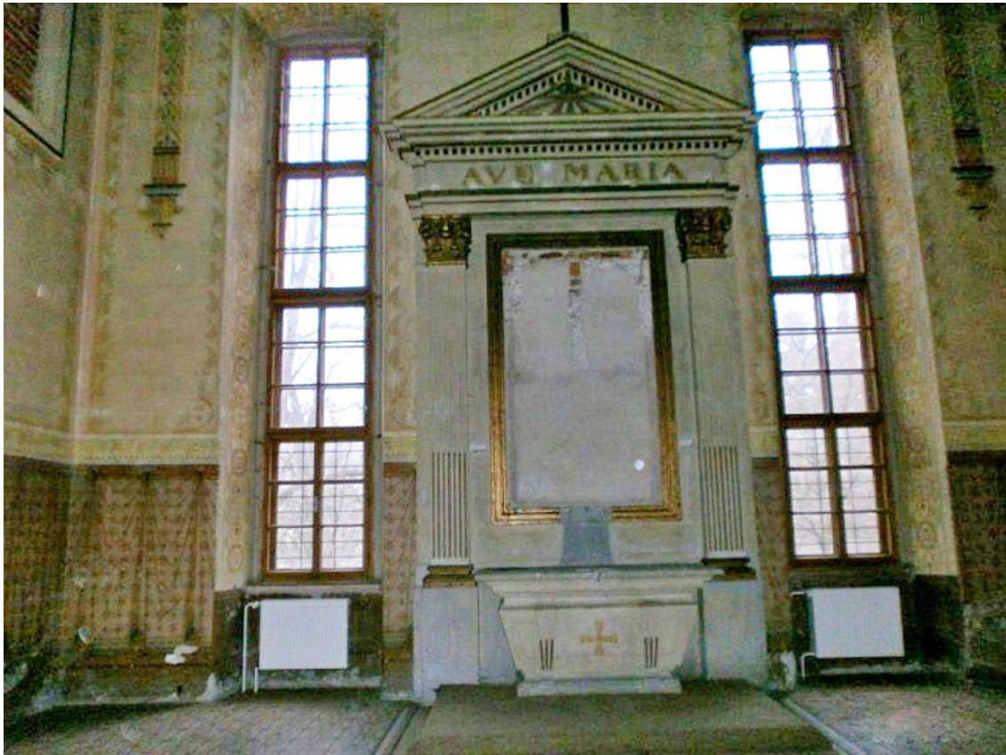
Pozostatky interiéru kaplnky v letnom sídle banskobystrických biskupov – súčasný stav 101
